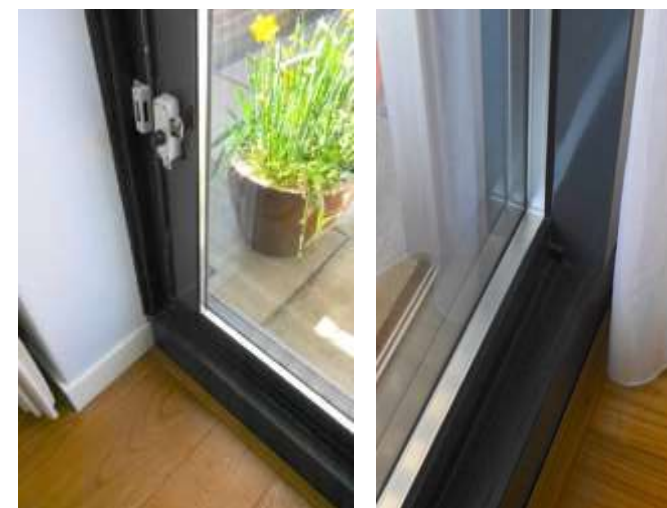
Aluminium schuifpui, HR + glas met 18 mm luchtspouw
