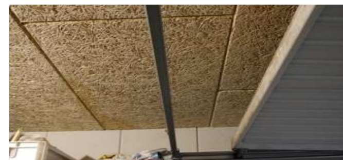
Isolatie vloeren boven garage
