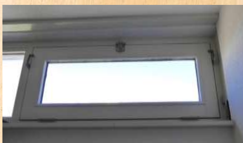
Valraam met kierstandhouder: ideaal voor spuiventilatie!
