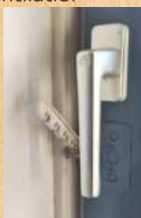
Valraam met kierstandhouder: ideaal voor spuiventilatie!
