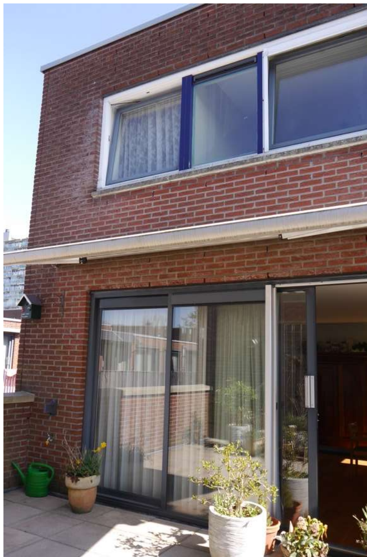
Aluminium schuifpui, HR + glas met 18 mm luchtspouw
