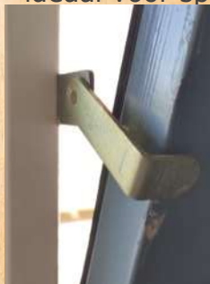
Valraam met kierstandhouder: ideaal voor spuiventilatie!
