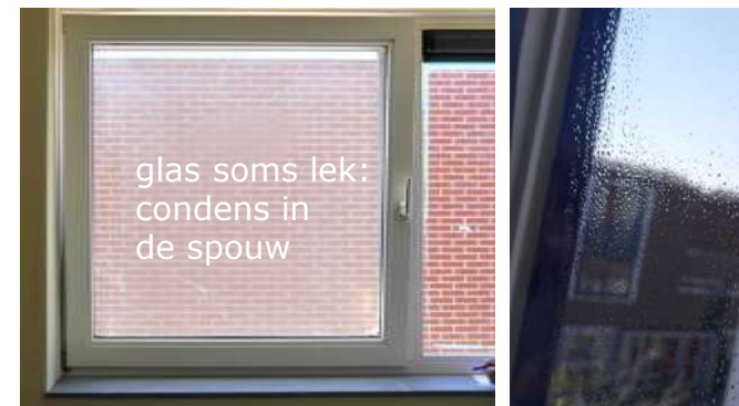
Houten kozijn + (groot) draai-kiepraam, isolatieglas met ca 10 mm luchtspouw
